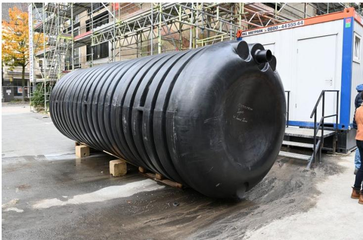
20-Kubikmeter-Tank für die Aufbereitung des Grauwassers.
