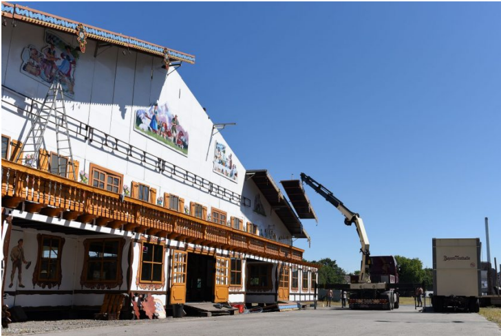
Arbeiten am Vordach des Bayernzeltes.
